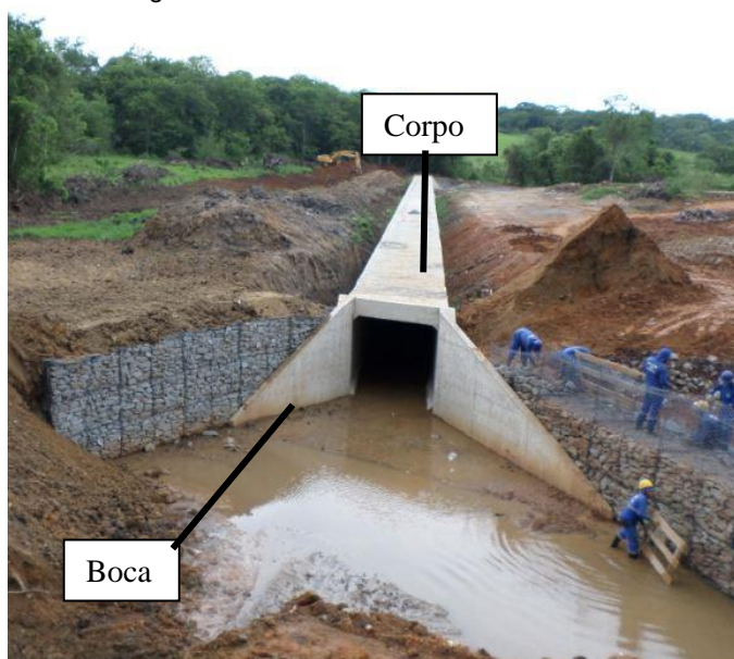
Figura 2. Partes constituintes de um Bueiro
